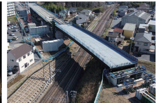
送り出し工法による橋桁架設完了
