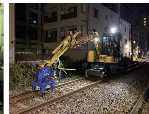
軌陸バックホウでの作業
