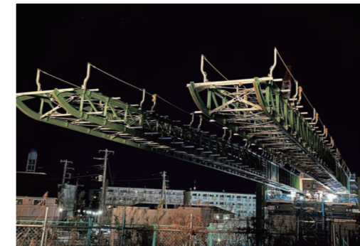
手延べ機による送り出し状況
