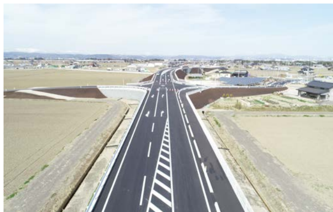
閑上小塚原線道路改良工事(宮城県名取市)
