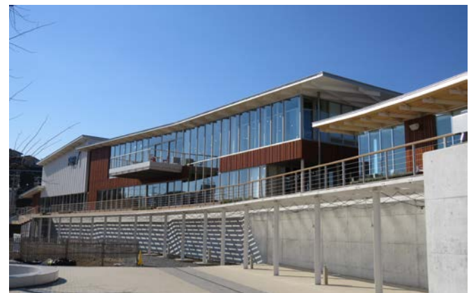
まち・ひと・しごと交流プラザ新築工事(宮城県気仙沼市)
