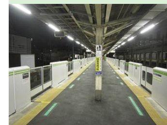
⑥設置完了
