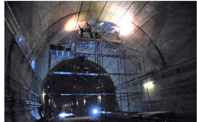
東北新幹線 那須トンネル 剥落修繕
