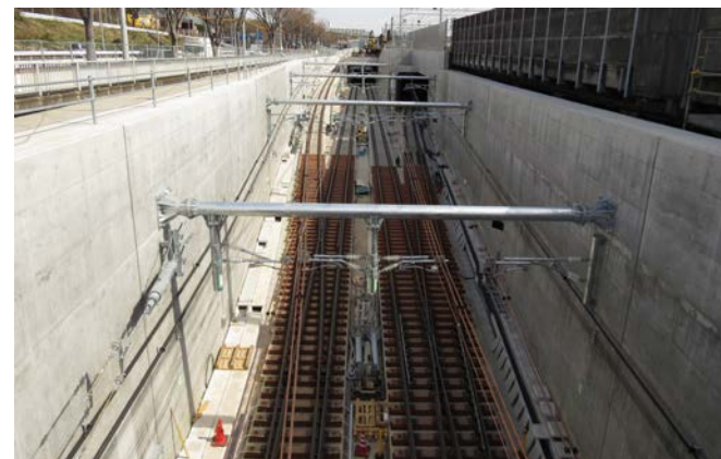
相鉄・JR直通線軌道敷設工事(鉄道・運輸機構)
