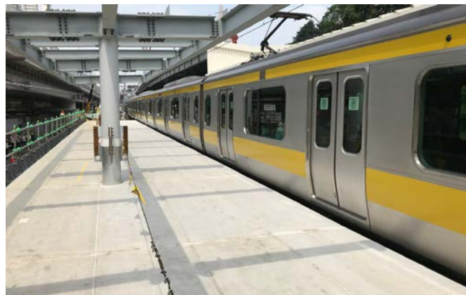
JR千駄ヶ谷駅改良工事(2020年4月完成予定)
