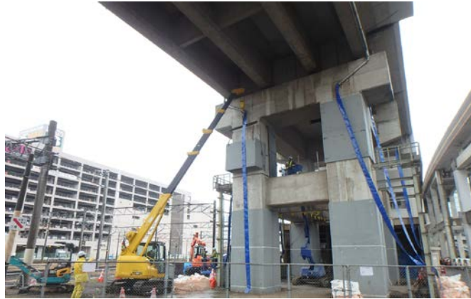
東北新幹線(郡山~福島)高架橋耐震補強
