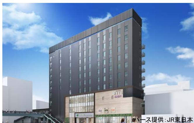
五反田メッツ新築工事(2020年1月完成予定)
