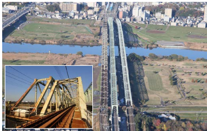
JR常磐線 利根川橋りょう改良工事
