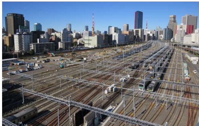
JR高輪ゲートウェイ駅付近 軌道改良工事
