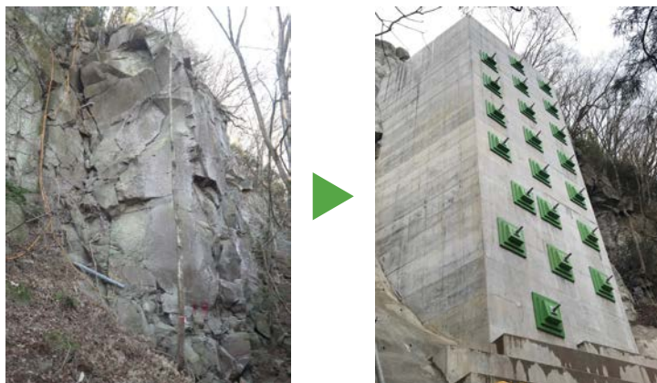
JR上越線 (津久田~岩本) 落石対策工事
