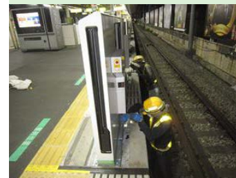
⑤ホームドア設置
