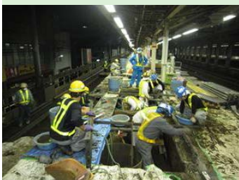
③受台設置
