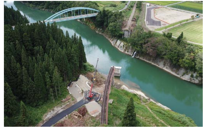
JR只見線復旧工事
