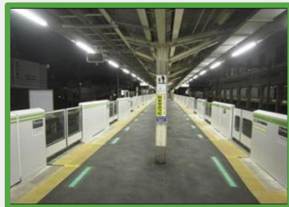
⑥設置完了
