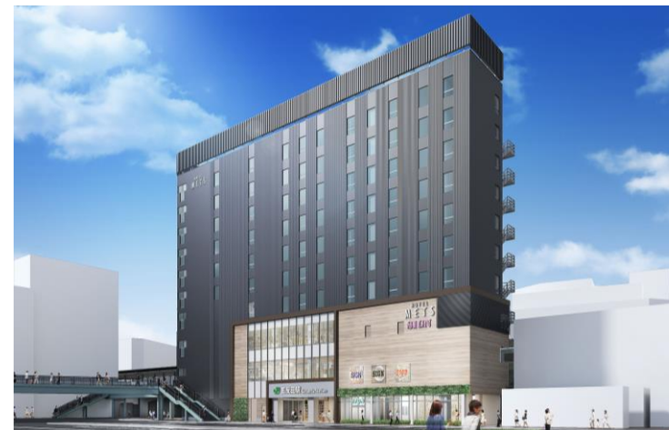
五反田メッツ新築工事(JR東日本・日本ホテル株)
