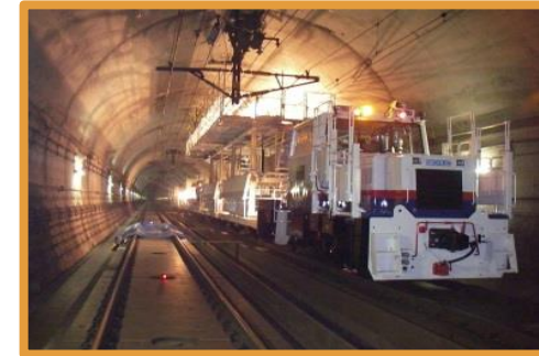
新幹線トンネル改修
