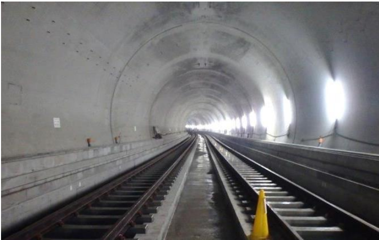
相鉄・JR直通線西谷軌道敷設工事(鉄道・運輸機構)
