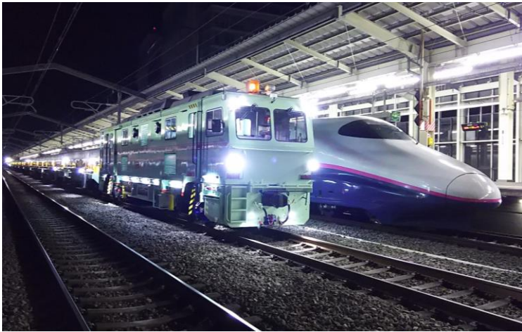
REXS(新幹線レール交換システム)
