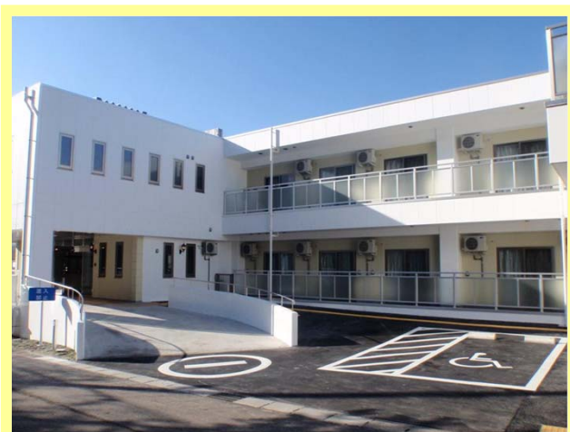
特別養護老人ホーム てらす鉤取新築工事 (宮城県 仙台市)
