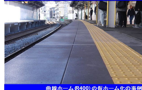
■多機能覆工板を使用しての民鉄での施工事例
