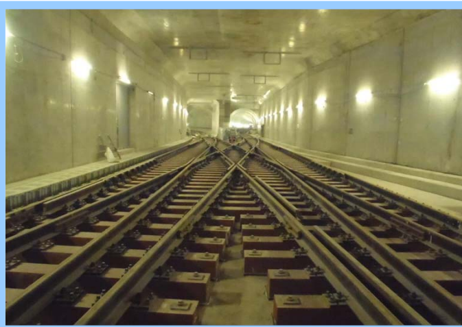
京王線 調布駅連続立体交差化軌道工事
