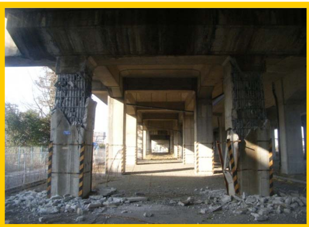
【東北新幹線 白石蔵王～仙台間 高架橋橋脚損傷】
