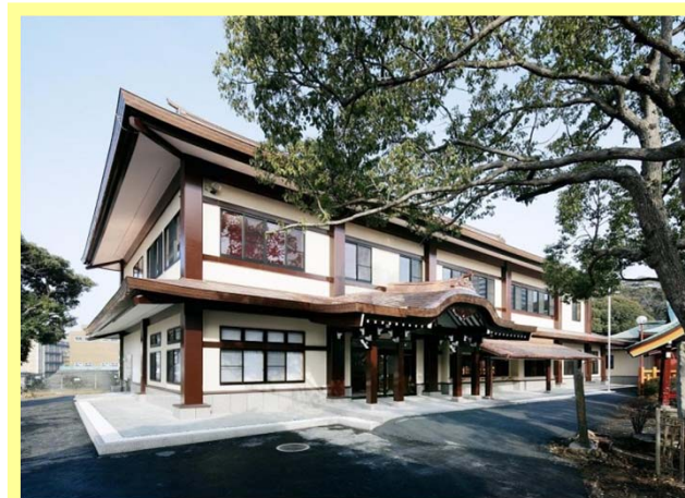
水戸東照宮 社務所新築工事
