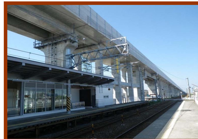
北陸新幹線 野々市高架橋新設工事
