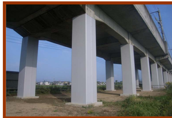
上越新幹線 橋脚耐震補強工事
