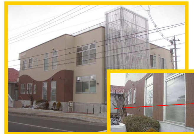
【復旧後】 (右下 冠水部分)
