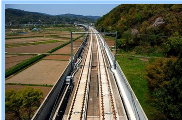
北陸新幹線（飯山工区）軌道敷設工事
