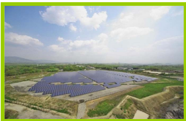
日本ルツボ豊田ソーラーパーク 建設工事(愛知県豊田市)
