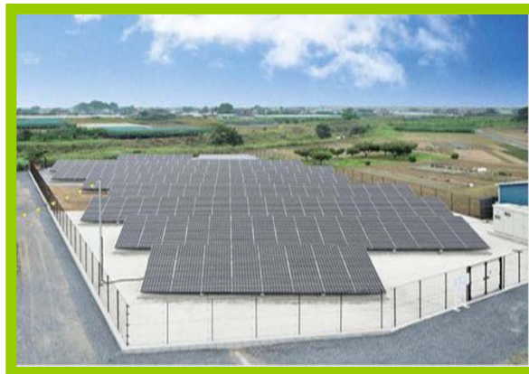
TOTETSU蓮田ソーラーステーション (埼玉県 蓮田市)
