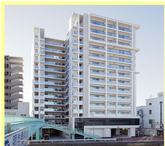
ライオンズ西日暮里マークスフォート新築工事
