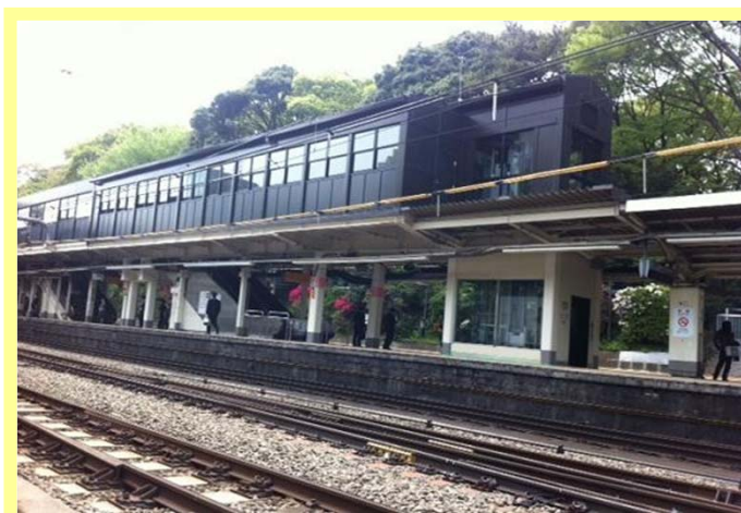
山手線 原宿駅バリアフリー化工事
