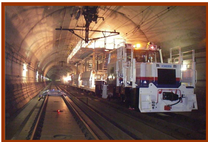
東北新幹線 トンネル耐震工事
