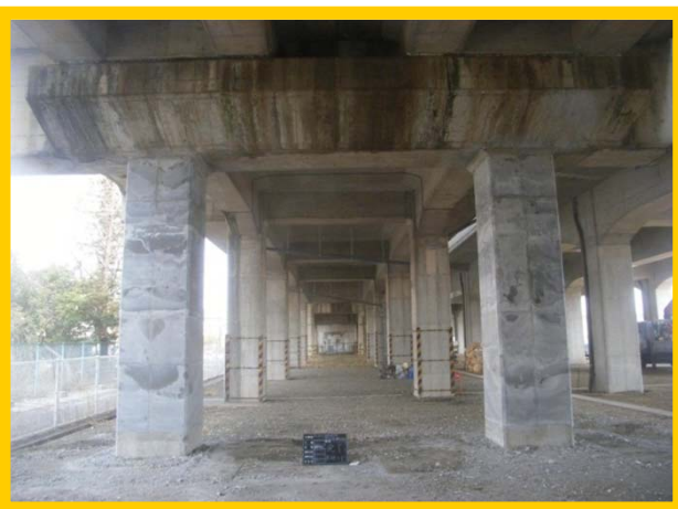
【復旧処置完了】
