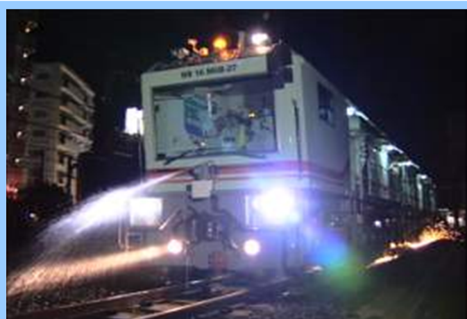
レール削正車による線路メンテナンス工事
