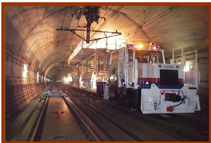
東北新幹線 トンネル耐震工事
