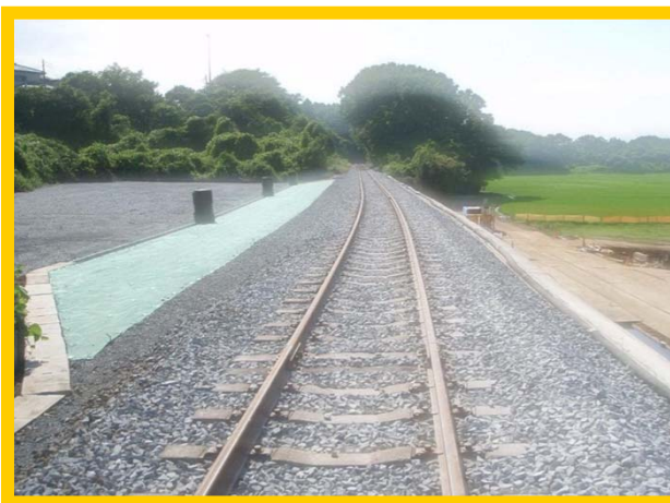
【復旧工事完了】
