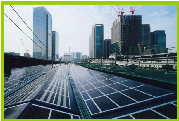
東京駅ホーム上家 太陽光パネル新設工事
