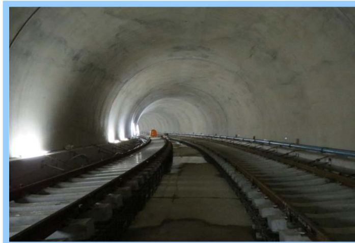
仙台高速鉄道東西線 軌道工事
