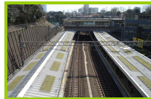
中央線 四ツ谷駅改良「エコステ」化 ホーム屋根上緑化工事
