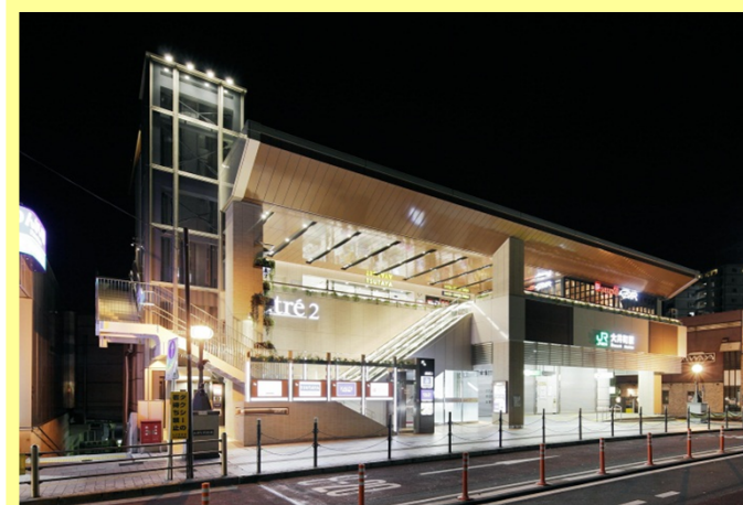
京浜東北線 大井町駅改良工事 (駅型保育園併設)
