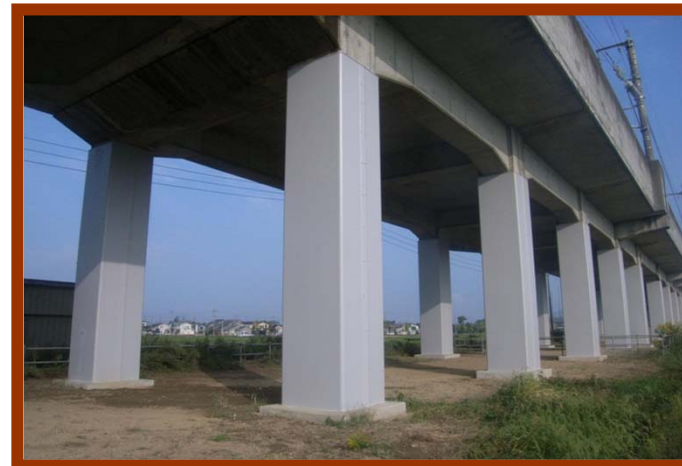
上越新幹線 橋脚耐震補強工事
