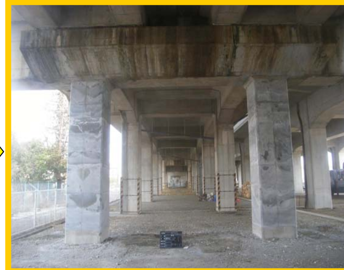
【東北新幹線 同左 復旧処置完了】
