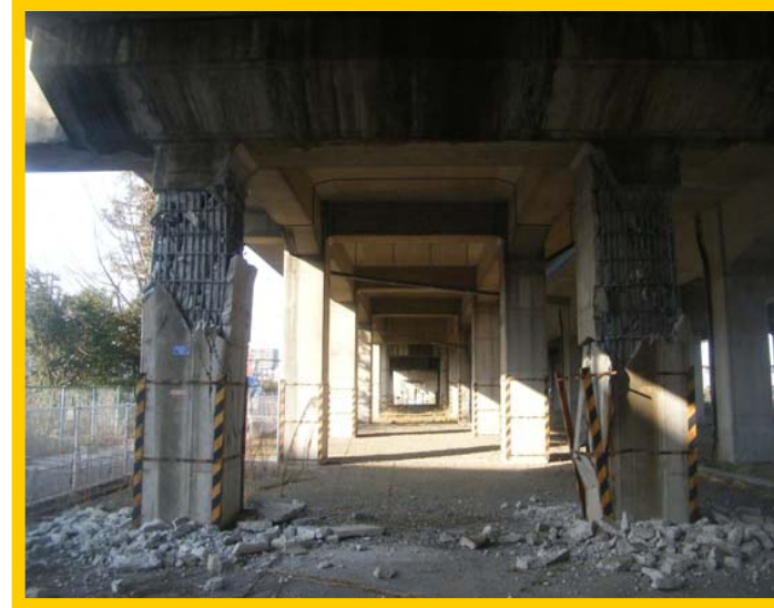
【東北新幹線 白石蔵王～仙台間 高架橋橋脚損傷】
