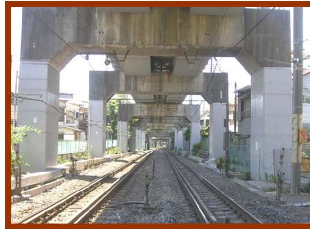
東海道新幹線 西大井・新川崎間 橋脚耐震補強工事
