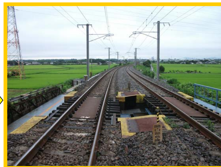
【常磐線 水戸～勝田間(復旧工事完了)】
