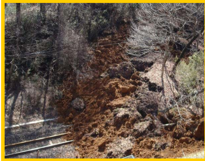
【東北本線 豊原～白坂間(土砂崩壊直後)】
