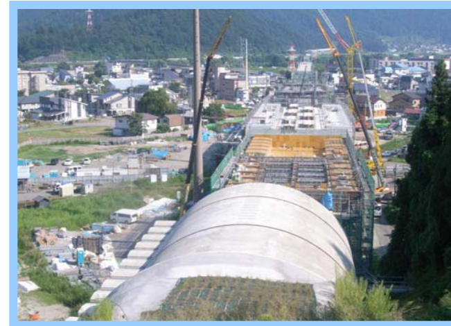
北陸新幹線（飯山工区）軌道敷設工事
