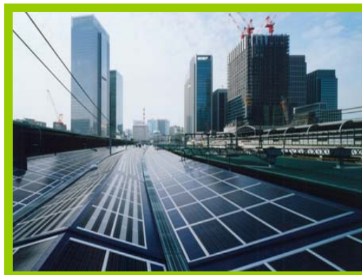
東京駅ホーム上家 太陽光パネル新設工事
