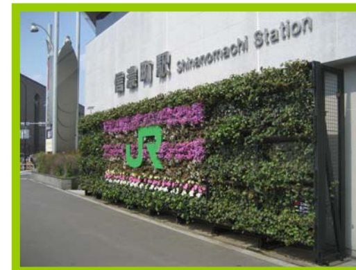
総武線 信濃町駅壁面緑化工事
