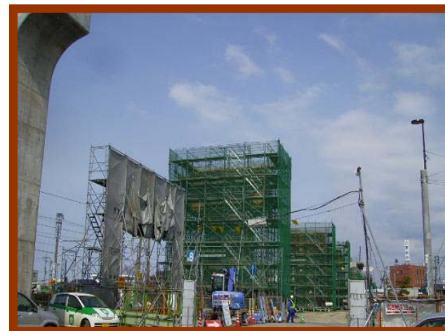
北陸新幹線 野々市高架橋新設工事
