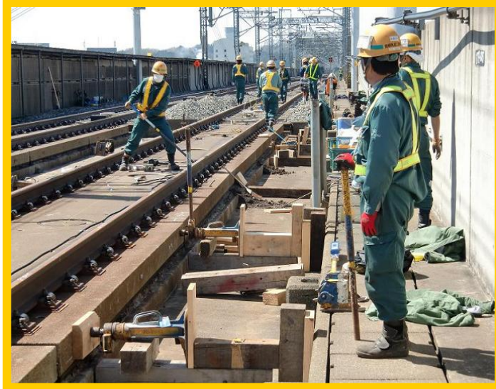
【東北新幹線 新白河駅付近(復旧作業)】
