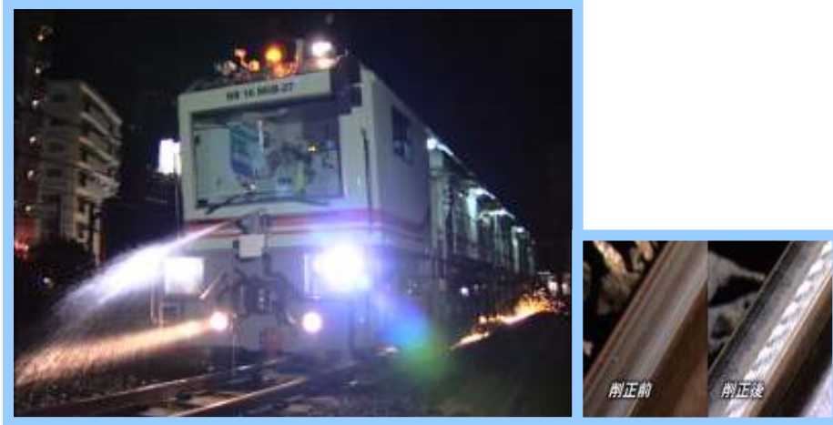
レール削正車による線路メンテナンス工事
