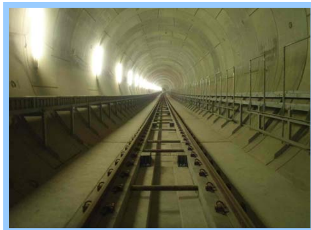
京王線 調布駅 連続立体交差化軌道工事
