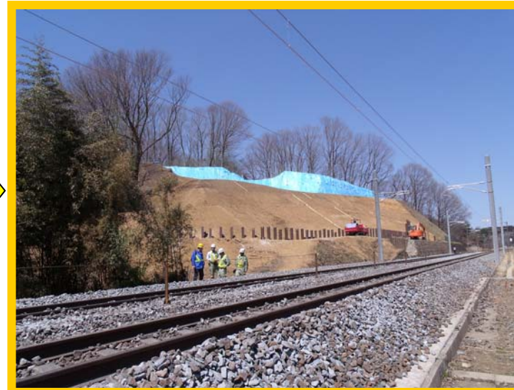
【東北本線 豊原～白坂間(復旧工事完了)】
