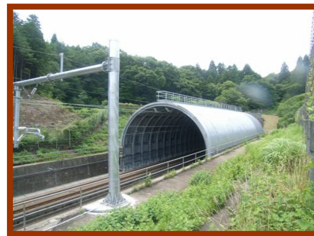
東北新幹線 トンネル緩衝工新設工事
