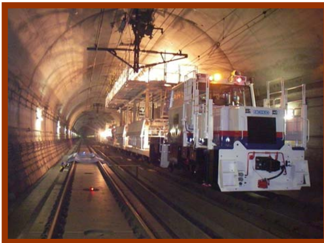
東北新幹線 トンネル耐震工事
