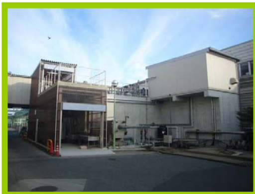
水処理施設(再生水製造装置)
