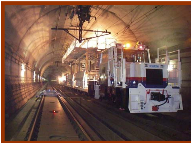
東北新幹線 トンネル耐震工事
