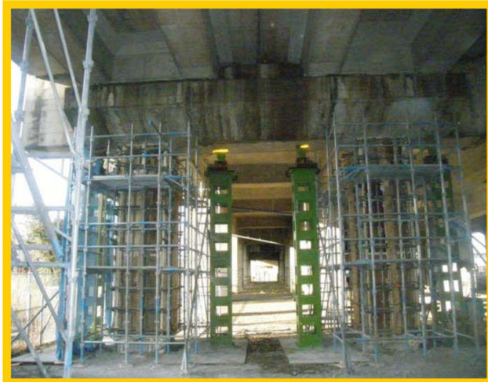
【東北新幹線 同右上 鋼製ベント仮受/無収縮モルタル施工中】
