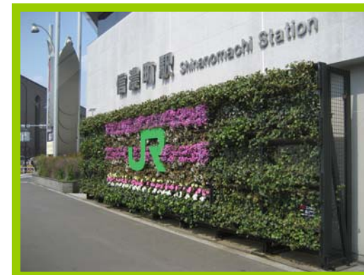
総武線 信濃町駅壁面緑化工事
