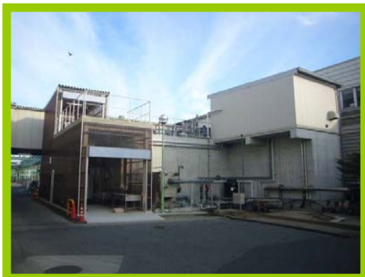
水処理施設(再生水製造装置)
