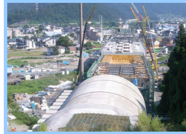
北陸新幹線（飯山工区）軌道敷設工事
