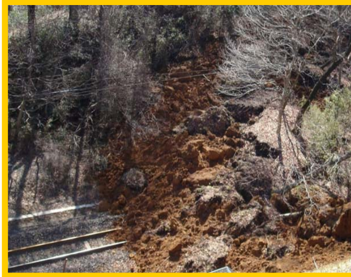
【東北本線 豊原～白坂間(土砂崩壊直後)】
