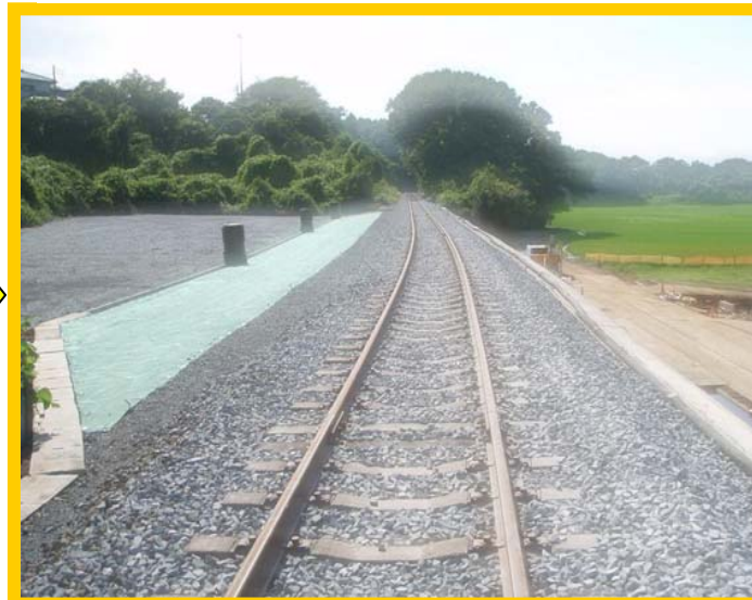
【ひたちなか海浜鉄道 金上～中根間(復旧工事完了)】
