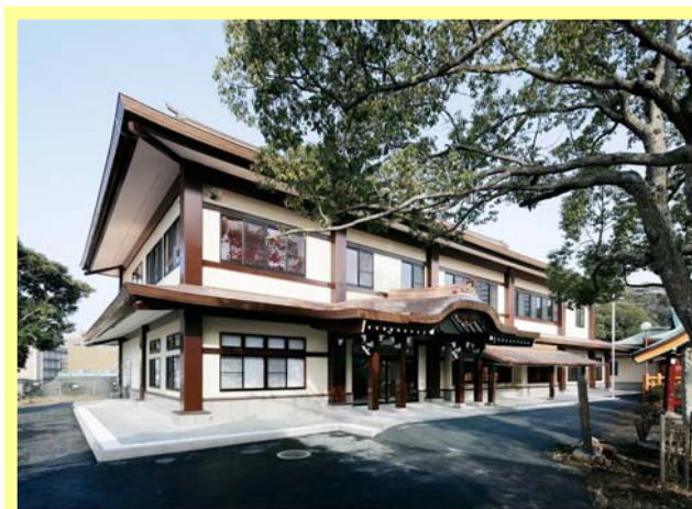
水戸東照宮 社務所新築工事
