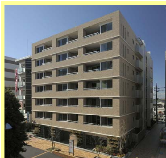
ライオンズ都筑ふれあいの丘新築工事
