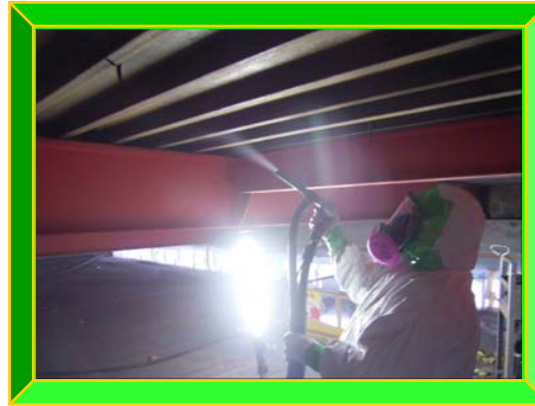
ドライアイスプラストによる除去
