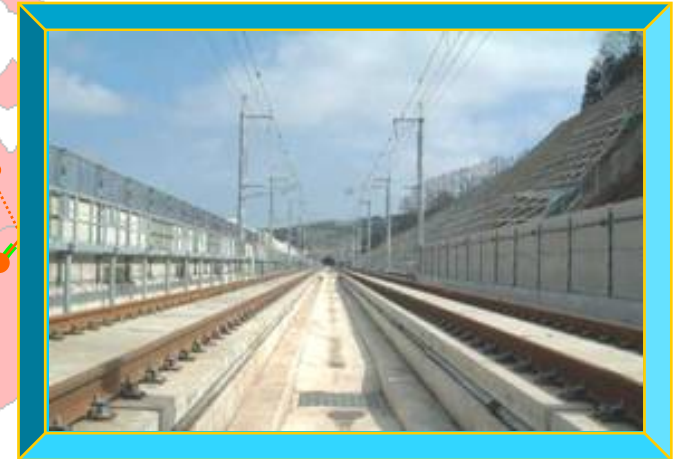
東北新幹線八戸・新青森間軌道工事 青森延伸区間の内、32kmの軌道工事を施工
