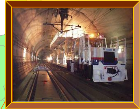
東北新幹線トンネル耐震対策工事
