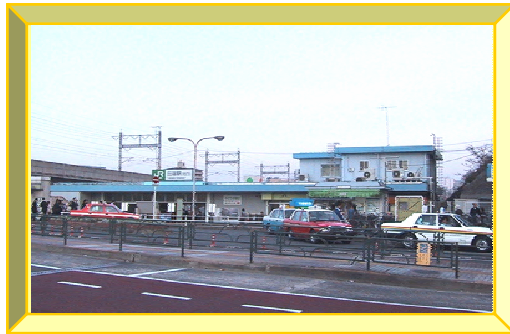
田端駅(旧駅舎)
