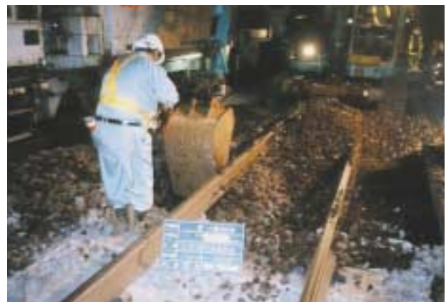
バックホーによる道床掘削
