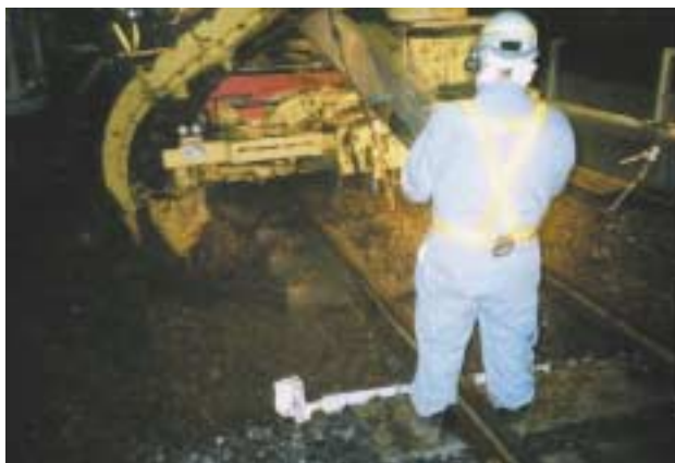
道床掘削機による道床掘削
