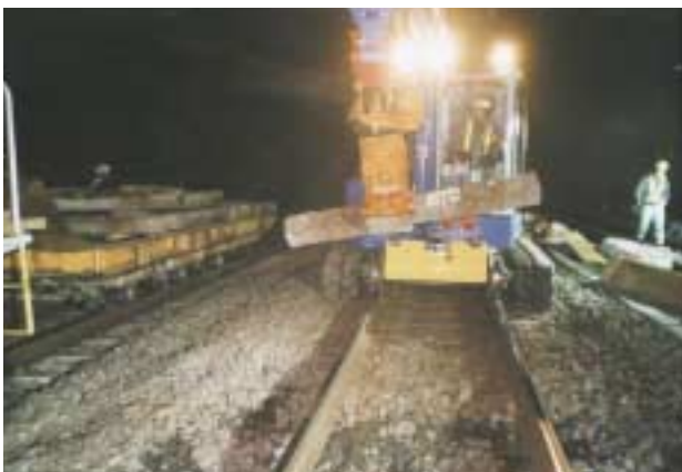
PCマクラギ撤去
