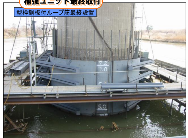
補強ユニット最終取付
