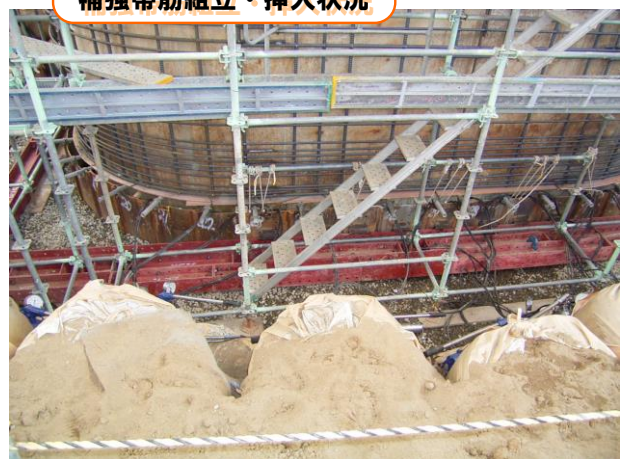
補強帯筋組立・挿入状況
