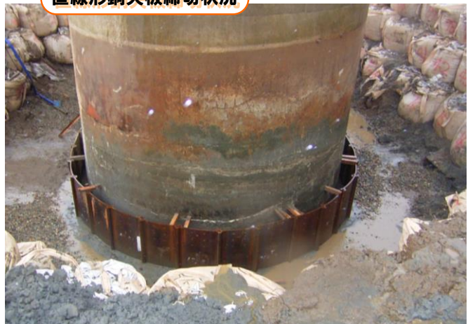
補強帯筋組立・挿入状況
