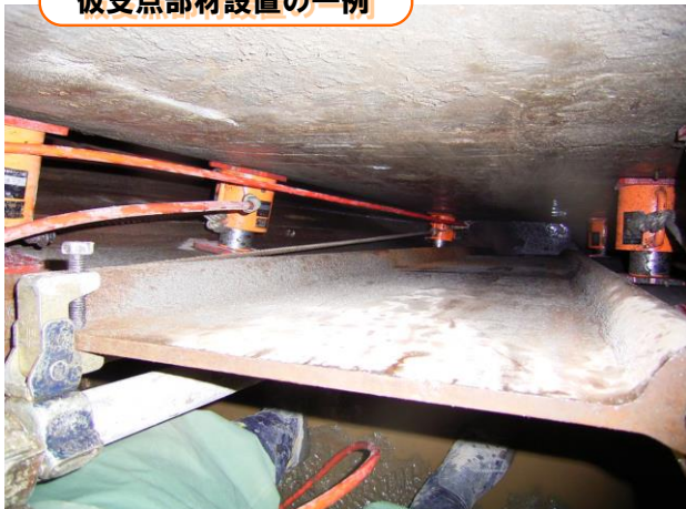
仮支点部材設置の一例
