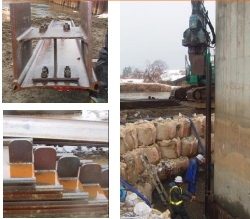
仮支点部材設置の一例
