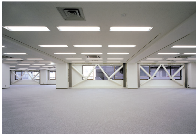
耐震補強 (制震装置)
