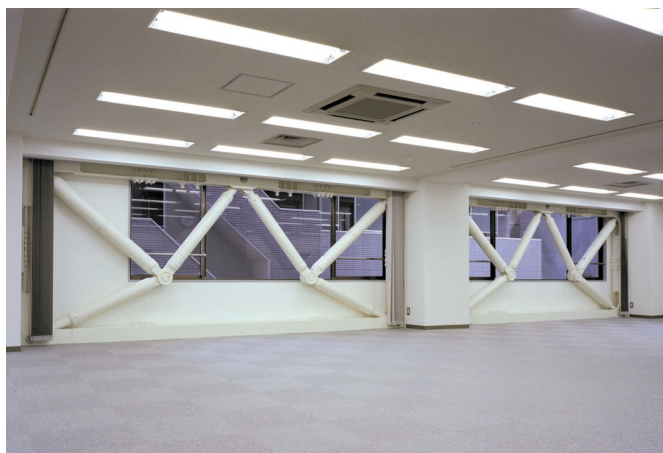
耐震補強 (制震装置)
